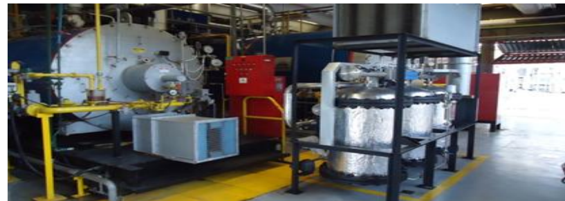
Tanques Vaporizador de etanol
